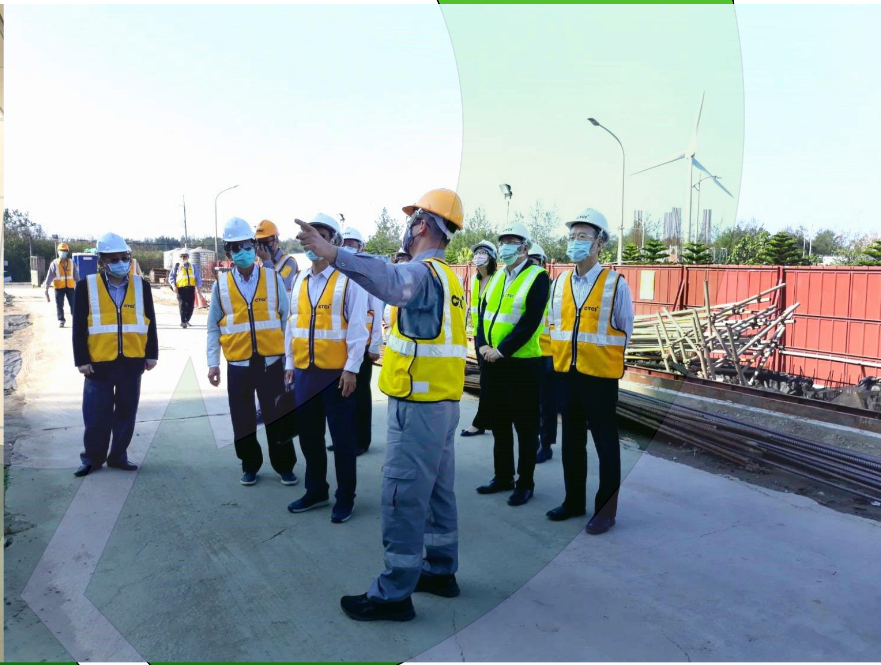
至桃園生質能中心 視察施工進度
